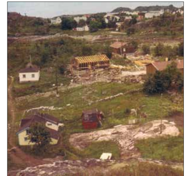
Kortvika 1970. “Gammelgården” med Nilsen-huset i bakgrunnen. Alf Løvlands hus er under bygging. Da Anton Olsen flyttet til Edvardsenhuset rett over veien, tok han med seg den gode mulden, som vi
